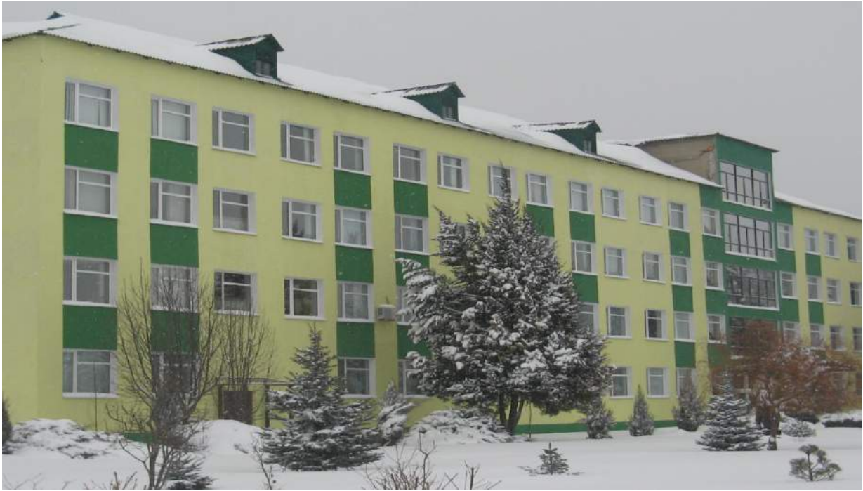
Фото 1. Навчальний корпус коледжу після капітального ремонту
